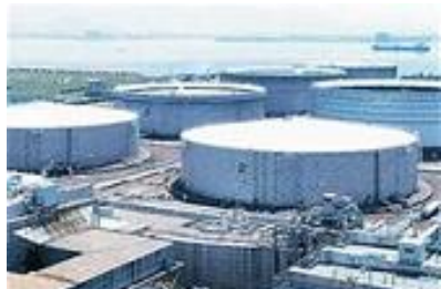
石油貯蔵タンク
