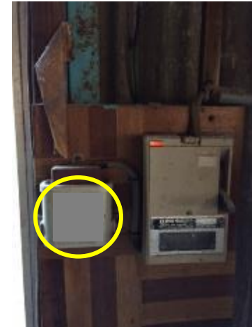
業務用乾燥機と分電盤に 設置されていた低圧コンデンサー ※上記写真のコンデンサーはPCB含有無し
