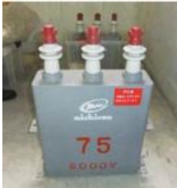
電力用コンデンサー
