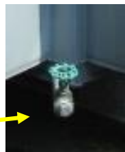
採取口付きの変圧器からの絶縁油の採取
